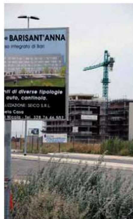
Nuovi quartieri Case in costruzione a Bari Sant'Anna
