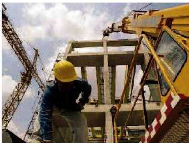
Un cantiere edile
